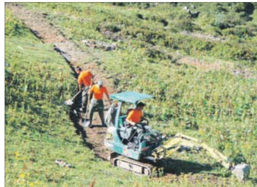
Eine Gruppe erstellt den neuen Abschnitt am Schächentaler Höhenweg.
