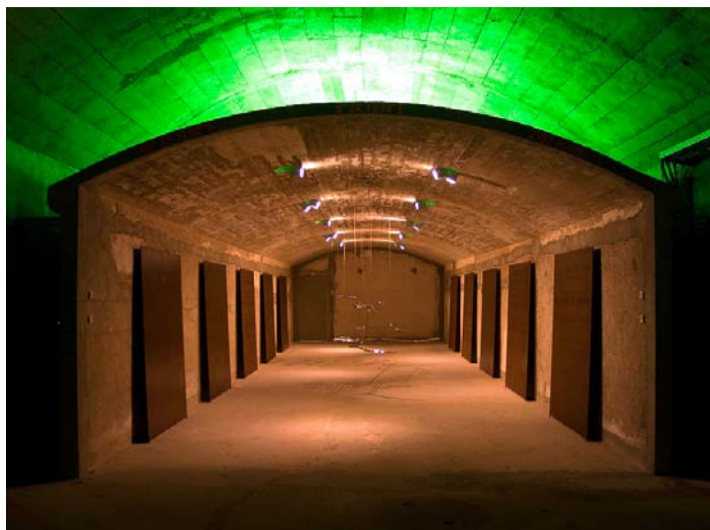
Eine von vielen unterirdischen Hallen, die sich im grössten Reduit der Schweiz befinden. Foto Peter Lienert
